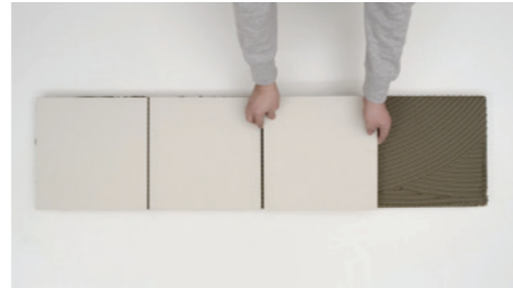
Verlegen der Fliesen
