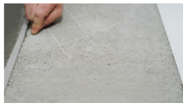
ZEMENTESTRICH Prüfung der Festigkeit und Reinigung
