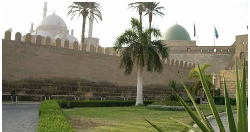
Ein Beispiel für aufsteigende Feuchtigkeit
